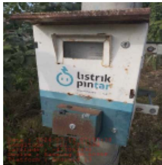
PENGECEKAN BOX KWH & KUNCI
