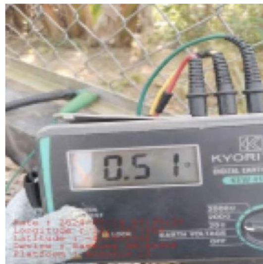
PENGUKURAN GROUNDING PAGAR
